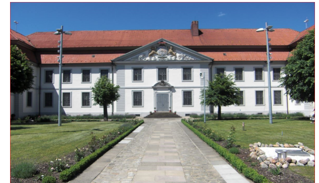
Eingang zur Anstaltskirche vom Südhof
